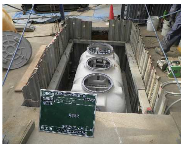
一般家庭への浄化槽設置（相模原市）
