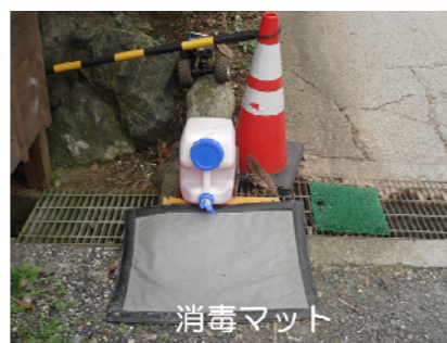
写真1 石灰帯及び消毒マットの設置状況
