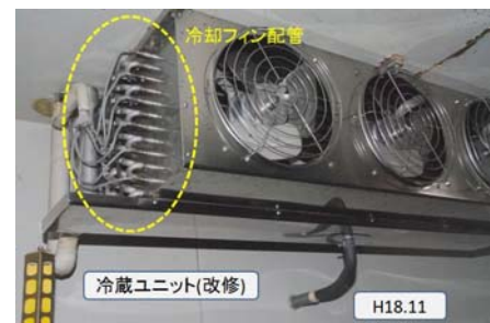
写真4 クーラーユニット
