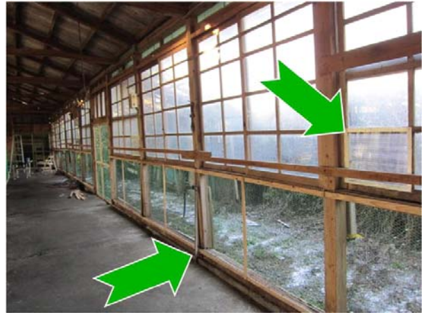
写真2 破損箇所への修繕
