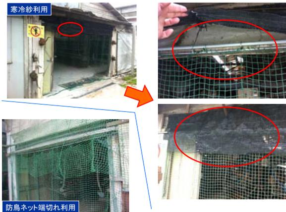
写真4 防鳥ネットの隙間対策
