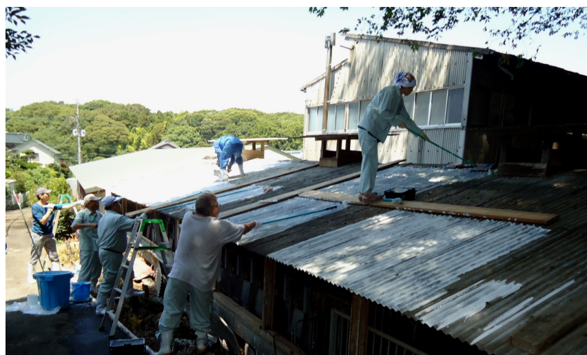
写真1 老朽化した屋根の破損防止対策
