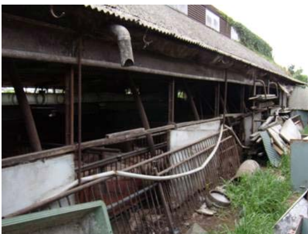
写真4 豚舎壁の一部撤去
