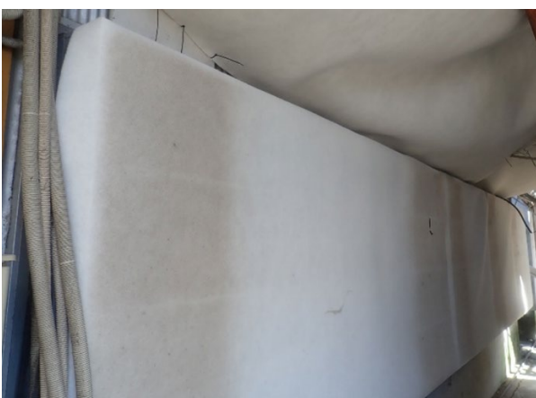
写真3 フィルターの状況
