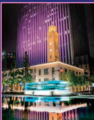
川崎市役所本庁舎
