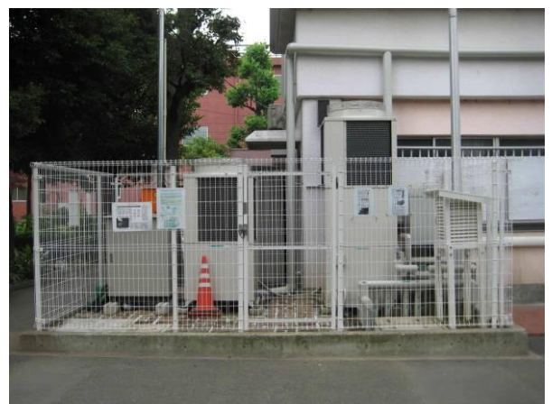
写真1 南河原こども文化センターの地中熱空調システムの実証装置（幸区）
