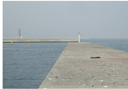
図2 東扇島波除堤
