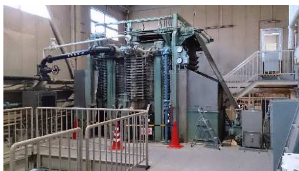
谷ヶ原浄水場排水処理施設
