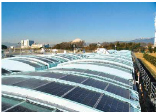
寒川第3浄水場太陽光発電設備
