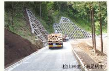
松山林道（剛足橋市）
