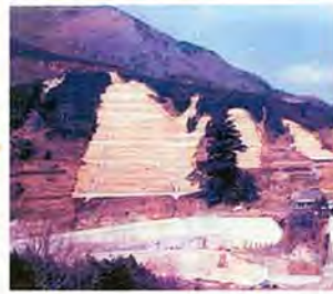
○山腹工施工状況（昭和49年）
