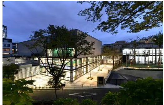
県立図書館外構等の再整備状況
