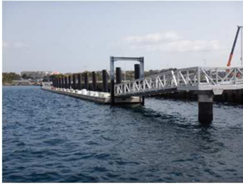
三崎漁港二町谷地区の浮棧橋
