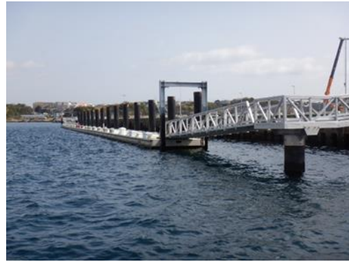
三崎漁港二町谷地区の浮棧橋
