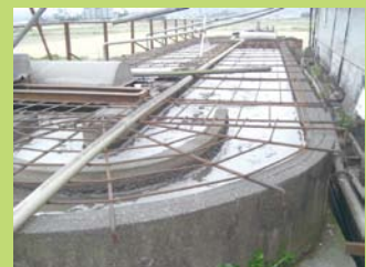
浄化槽処理の様子
