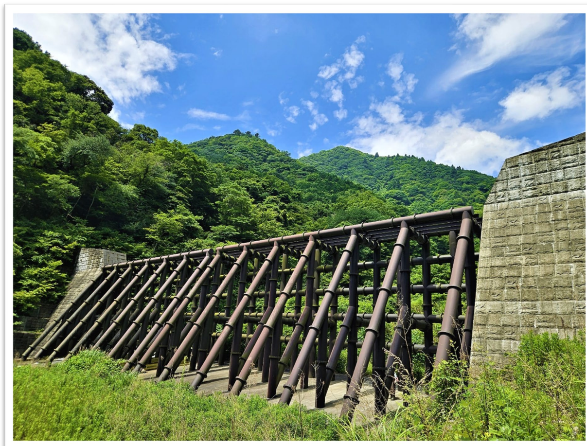
ろうそうぼう えんてい 老僧坊第二堰堤 (湯河原町) 令和6年6月撮影
