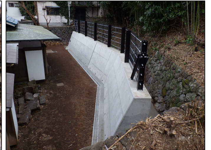
待受式擁壁工 清水澤地区（真鶴町）
