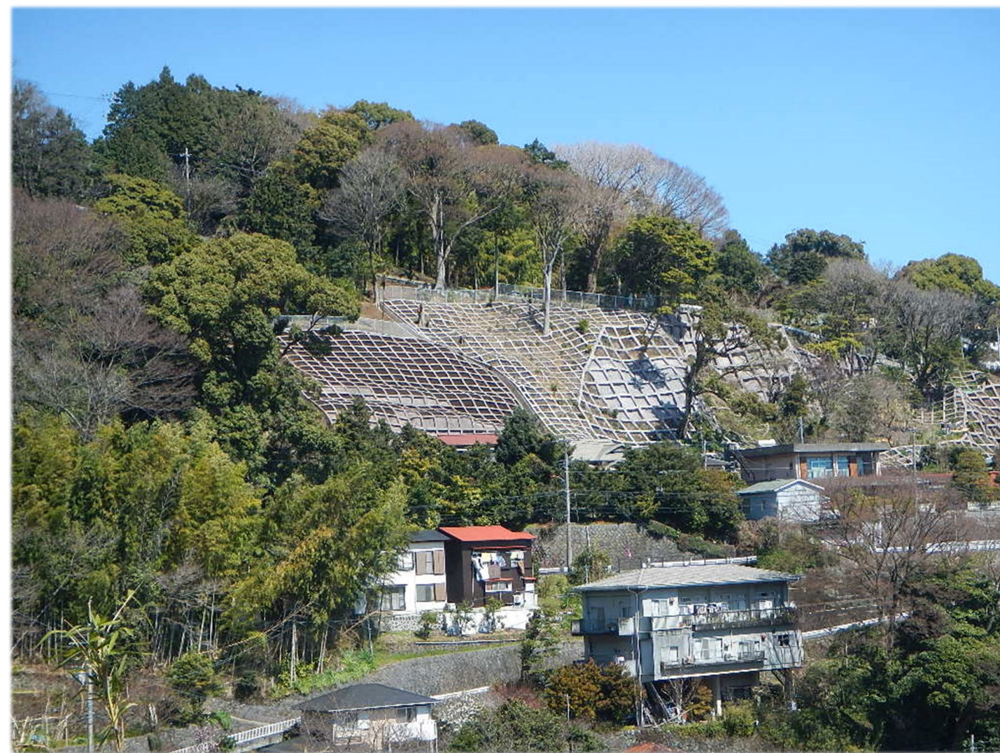
急傾斜地崩壊危険区域 根府川C地区（小田原市）
