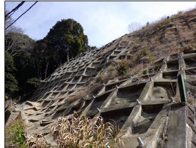
アンカー付き法枠工 道中地区（湯河原町）
