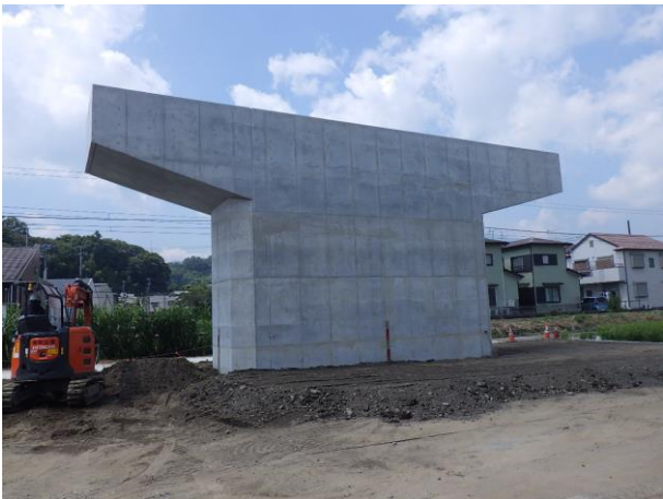
P4 橋脚完成
