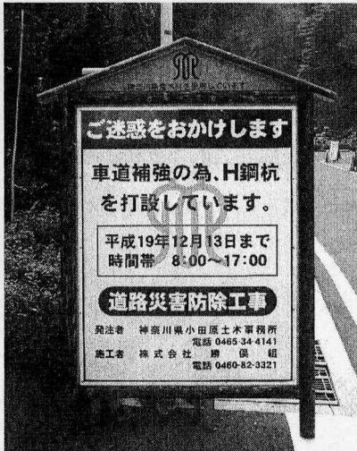
写真4 木製道路工事表示看板
