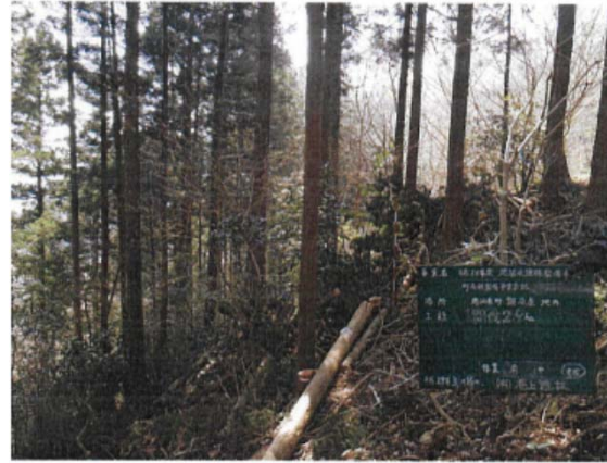
施工後(平成28年度)
