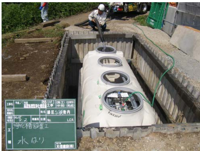
長屋への浄化槽設置(10人槽)
