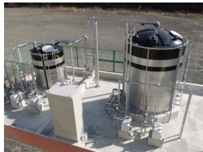
凝集剤添加設備
