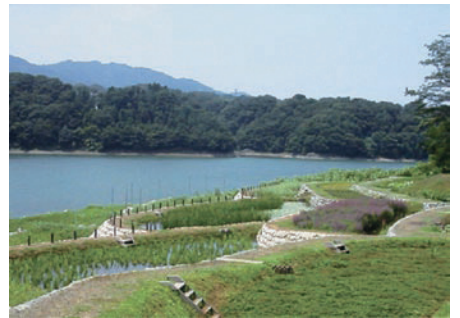
津久井湖畔の植物浄化施設
