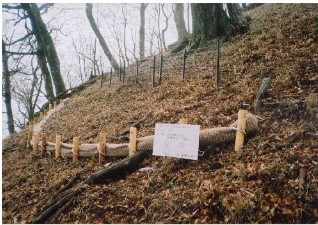
土壌流出防止対策（清川村 丹沢山東側山腹斜面）
