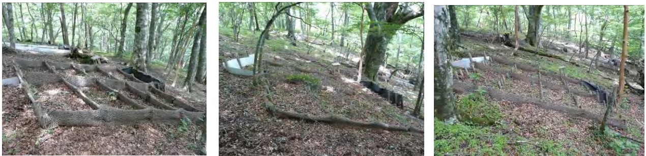
写真 2009年7月時点の対策工の状況 (左：捕捉ネット工 中央：リターロール工B 右：竹袋土嚢工)
