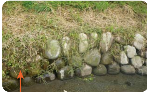
自然石の空積みによる、水質浄化対策
