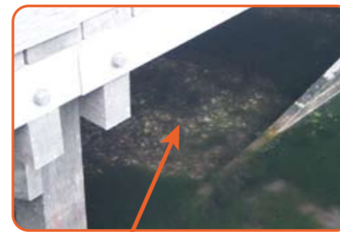
カキ殻の設置による水質浄化対策
