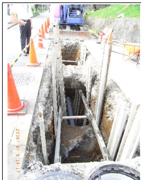
公共下水道の開削工事 （相模原市津久井町根小屋）
