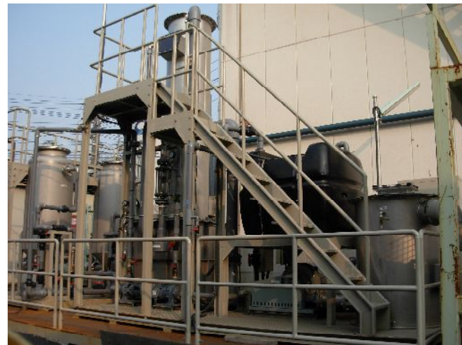
秦野市の地下水浄化設備
