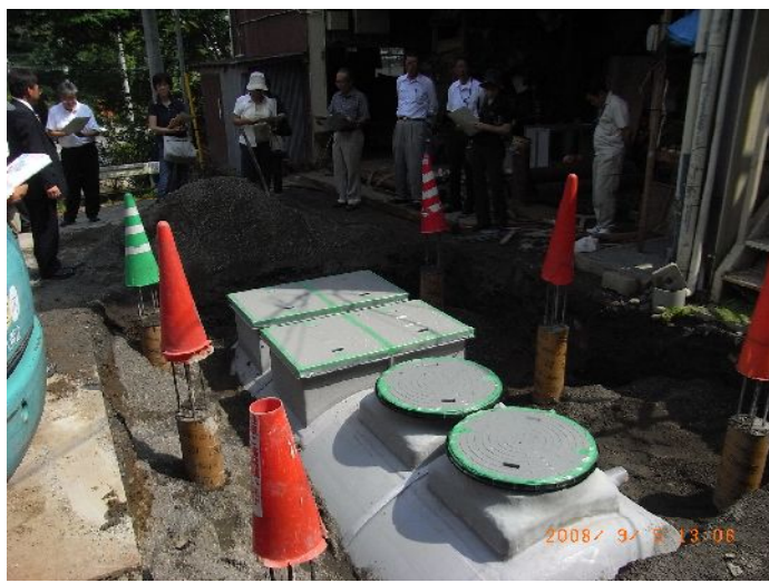
合併処理浄化槽の設置工事（相模原市藤野町沢井）
