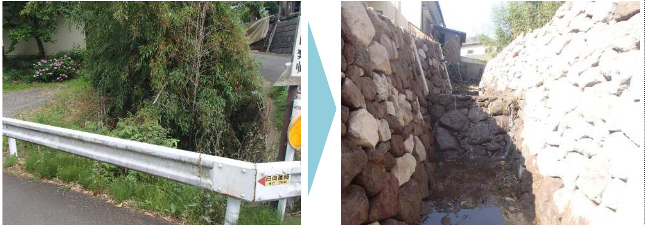
自然石による護岸とし、礫間浄化を促進させた。
