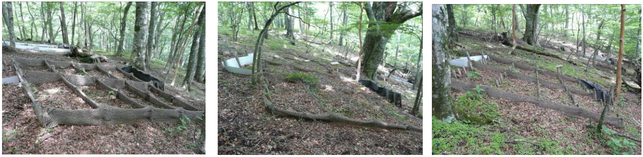
写真 2009 (H21) 年7月時点の対策工の状況 (左：捕捉ネット工 中央：リターロール工B 右：竹袋土嚢工)
