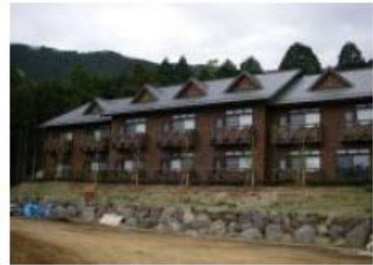
市場で取引された丸太は製材所等で加工され、住宅や公共施設等に使われます。 (写真は、秦野市表丹沢野外センター)
