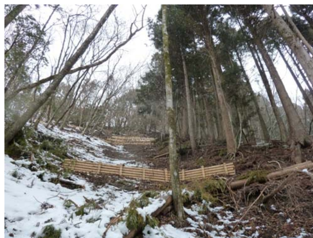
溪畔林と溪畔人工林 丸太柵等設置（仲の沢）
