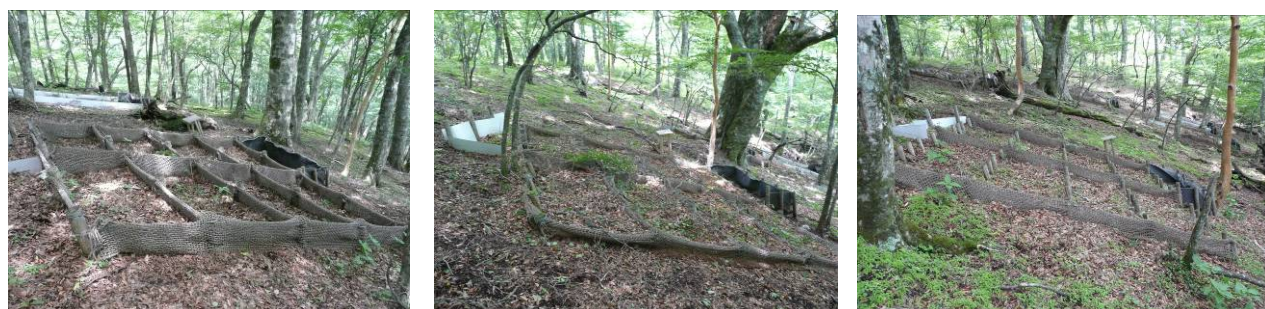
写真 2009 (H21) 年7月時点の対策工の状況
