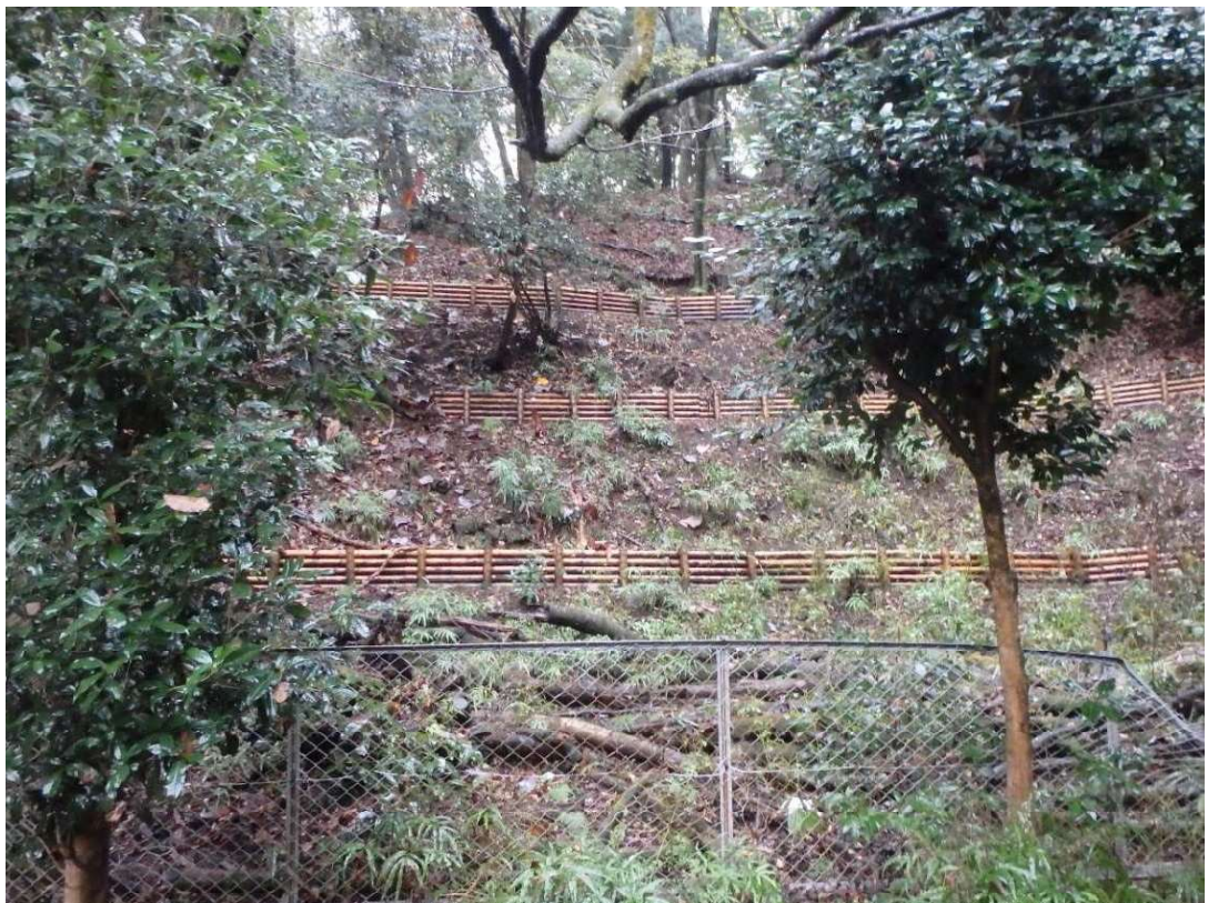
▲土壌保全工(丸太柵工)が設置された視察現場
