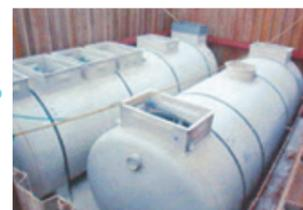
高度処理型合併処理浄化槽
