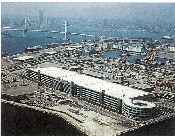
横浜の輸入促進地域（FAZ）拠点 横浜港流通センター
