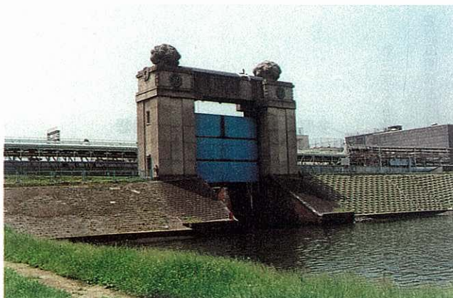
運河計画の出発点 川崎河港水門
