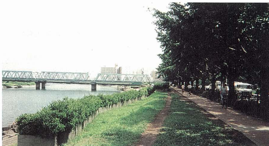
多摩川サイクリングコース
