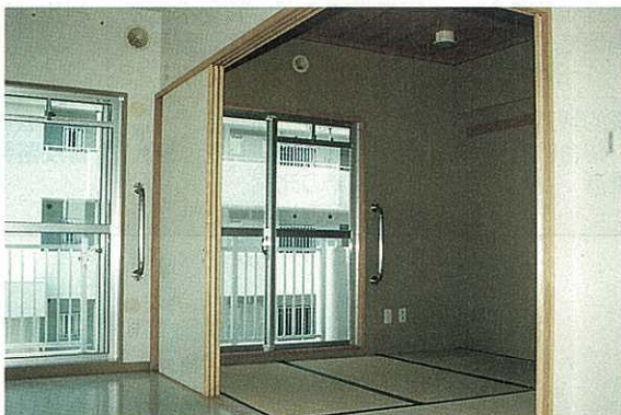
シルバーハウジング（段差の解消、手すりの設置）
