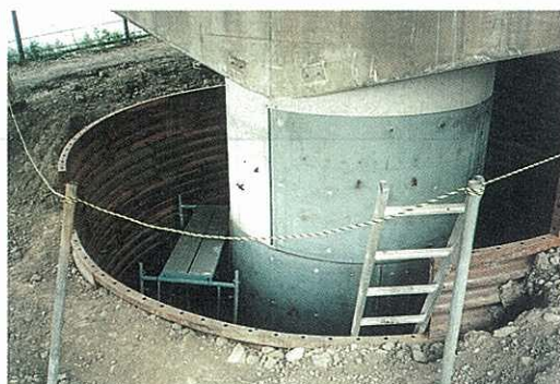
県道22号（横浜伊勢原線） 門沢橋 橋脚の耐震補強
