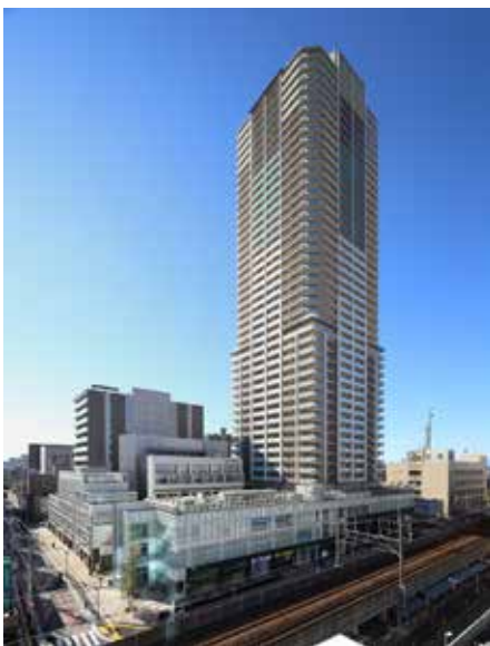
建設中の新東名高速道路、リニア中央新幹線、小杉町3丁目中央地区市街地再開発事業
