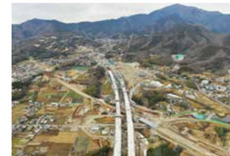
新東名高速道路 伊勢原大山インターチェンジ
