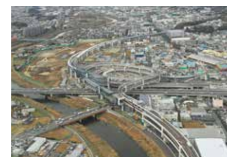
高速横浜環状北西線 横浜港北ジャンクション
