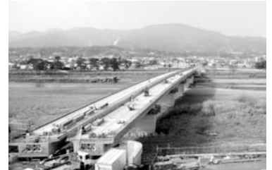
小田原環状道路・酒匂川1号橋
