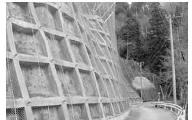
道路法面の防災工事・県道70号
