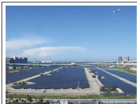
川崎市にあるメガソーラーの発電所
