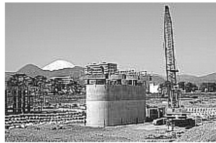
酒匂川2号橋の整備
