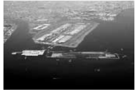
羽田空港口滑走路工事全景(2009年3月撮影) (東京空港整備事務所提供)
