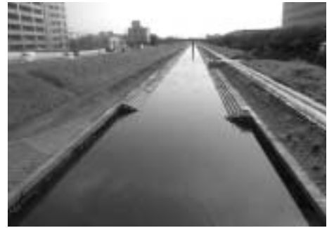
河床掘削の完了した柏尾川
