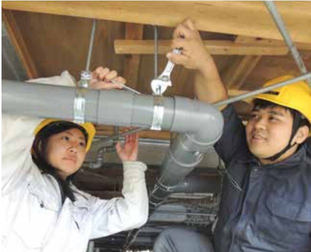
建物施工の職業訓練の様子
