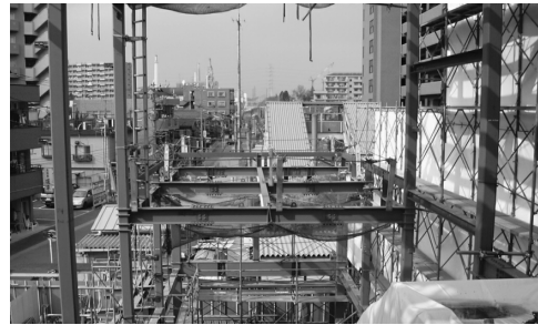
南橋本駅東西自由通路の整備
