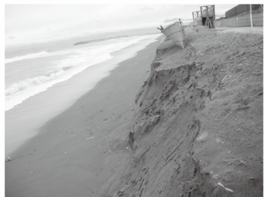
茅ヶ崎海岸の侵食状況
