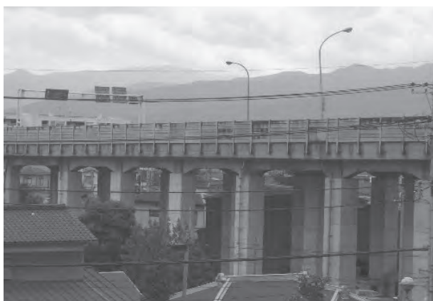
①国道 255 号（松田高架橋）耐震補強
