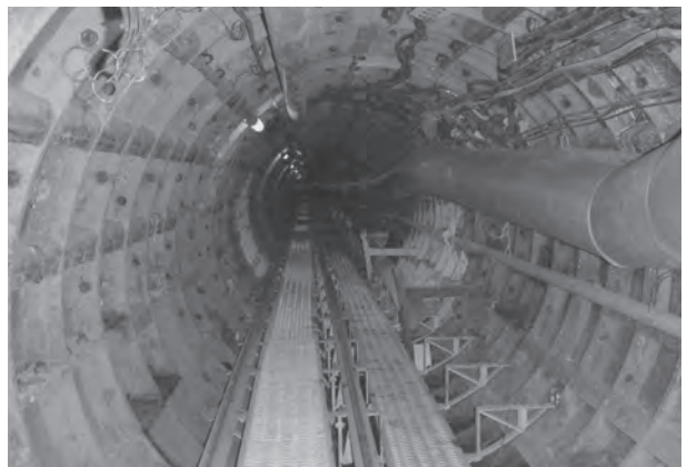
⑬大和市上和田地内配水管布設（工事中）
