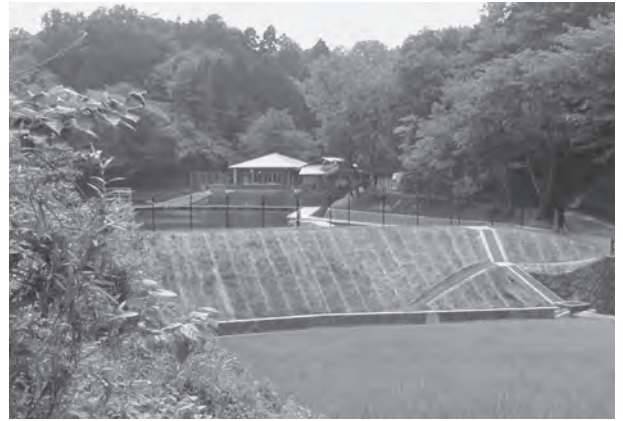
⑥寺家地区ため池改修
