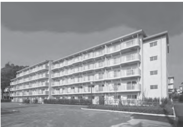
⑫県営追浜第二団地第1期建設工事
