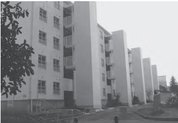
⑪県営いちょう上飯田団地トータルリモデル建築工事
