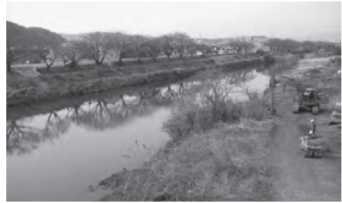
多自然型護岸整備（金目川）
