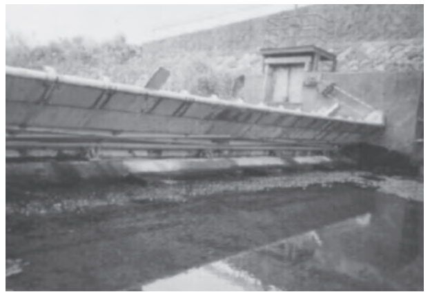
⑦万年堰地区取水堰整備
