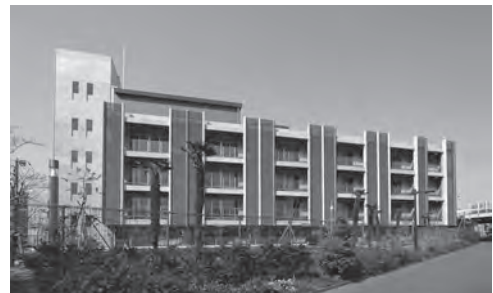
リーディングベンチャープラザ2号館
