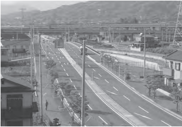
⑨小田原環状道路整備
