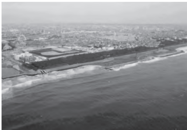
②茅ヶ崎海岸消波堤整備
