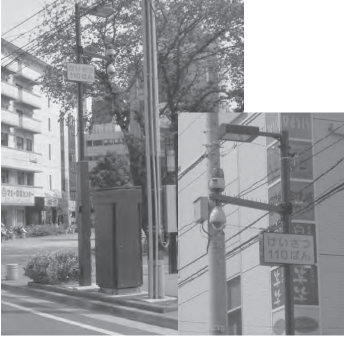
⑱スーパー防犯灯設置整備（本厚木駅前）
