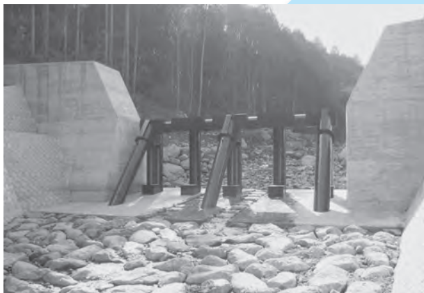
③唐沢川餅搗場えん堤整備
